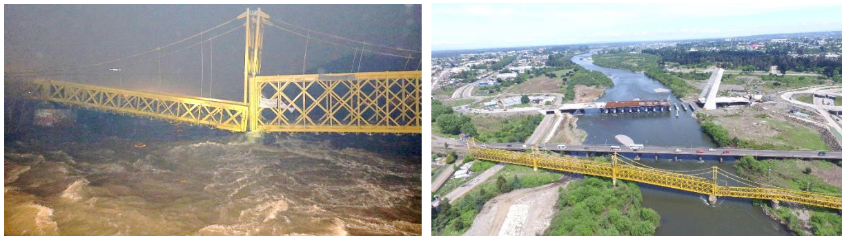
Figura III-20 Registro de colapso puente ferroviario por socavación y desplazamiento de cepa central, crecida del 27 de junio de 2018
